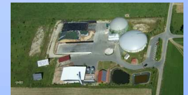
Bioenergieanlage Jühnde, Centrum Neue Energien
